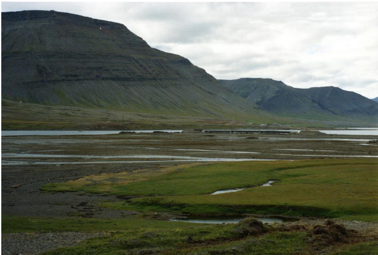
Mynd 1. Dýrafjarðarbrú í byggingu í ágúst 1990 (Ljósm. Gísli Eiríksson).
